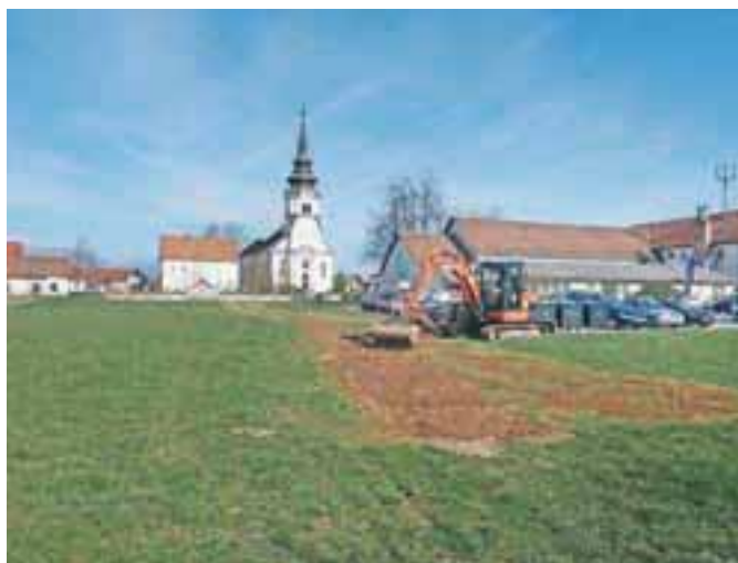
Arheologi so prva izkopavanja na mestu bodočega središča Vodice že opravili, a v prihodnjih mesecih se bodo še vrnil. Našli so namreč ostanke iz rimske dobe.
