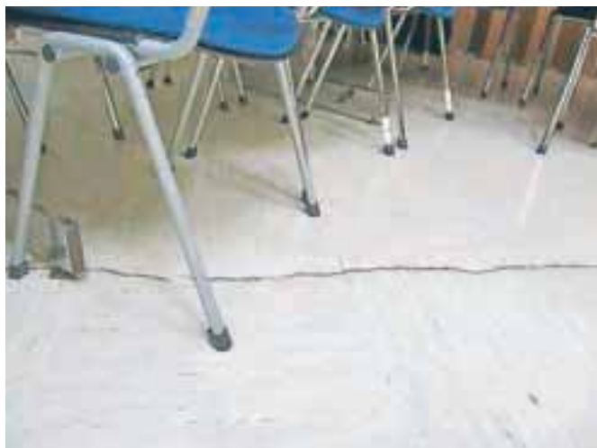
Zaradi žlindre so tla v zbornici in nekaterih učilnicah razpokana in dvignjena.
