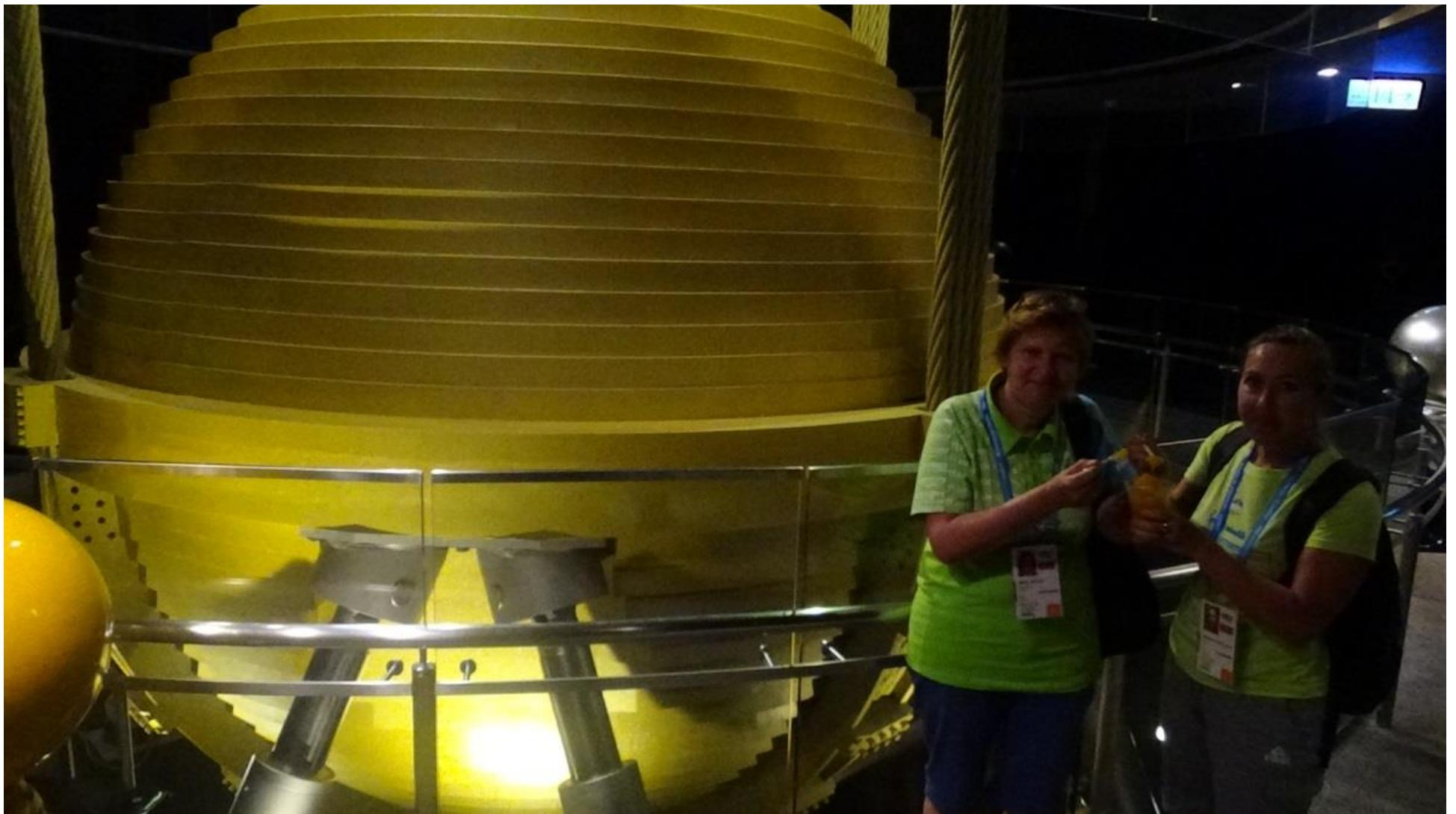
**ICG New Taipei (TJV) 2016 – Taipei 101, 728 tonski stabilizator zgradbe na 87 nadstropju**
